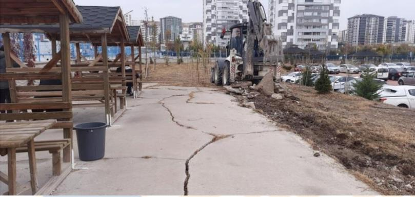
Okul girişinde yer alan kamelyaların önündeki kırık zemin betonu **Okul Aile Birliği imkânlarımızla** kepçe ile aldırılmıştır. Bu kırık beton parçaları güvenlik kulübesi montajı yapılırken sökülmesi gereken kamelya zemini için dolgu malzemesi olarak kullanılmıştır.
